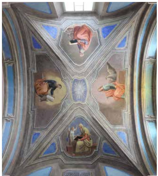
Decorazione della volta del presbiterio dopo i restauri, foto A. Meregalli, Archivio UBC
